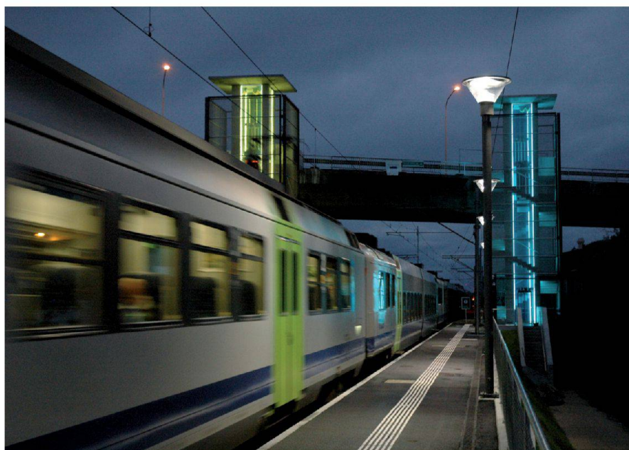
Fig. 6: Revalorisation de la zone urbaine: A Niederwangen, des tours assurent la liaison entre le centre, les quartiers d'habitation et les zones artisanales séparés par l'autoroute A12. (Clemençon + Ernst Architekten/Bächtold AG, 2010). (Photo © Gemeinde Köniz.)
