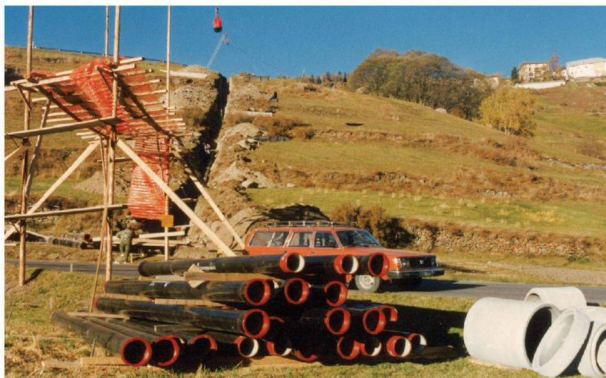
Abb. 3: Druck- und Abwasserleitung Guarda-ARA.
