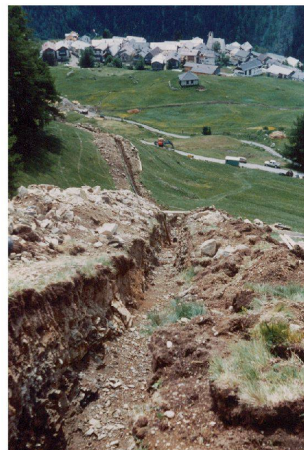
Abb. 1: Graben für Druckleitung Funt. N.–Charal.
