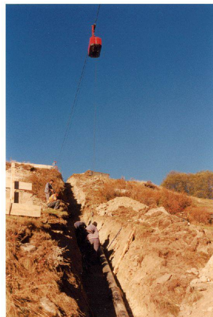
Abb. 5: Druckleitung und Abwasserleitung Guarda–ARA mit Transportseilbahn.
