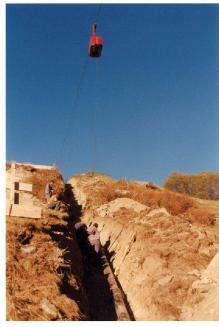
Abb. 5: Druckleitung und Abwasserleitung Guarda–ARA mit Transportseilbahn.
