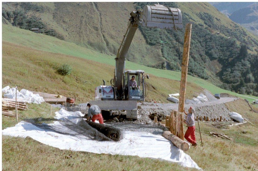
Abb. 2: Querung eines Flachmoores mit Einbau von Rundholz und Schaumglasschotter.
