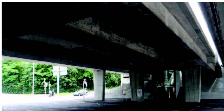
Fig. 2: Les ponts de Pré-Bois, des ouvrages complexes avec des escaliers, passages inférieurs et ascenseurs intégrés aux culées.
