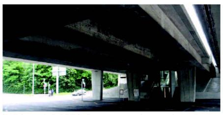
Fig. 2: Les ponts de Pré-Bois, des ouvrages complexes avec des escaliers, passages inférieurs et ascenseurs intégrés aux culées.
