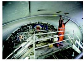
Abb. 9: Einbau einer tShape-Messkette für Konvergenzmessungen hinter dem Bohrkopf der TBM.
