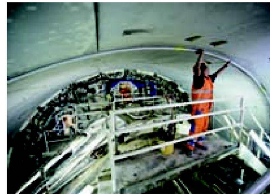
Abb. 9: Einbau einer tShape-Messkette für Konvergenzmessungen hinter dem Bohrkopf der TBM.
