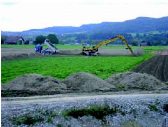
Abb. 3 und 4: Landwirtschaftliche Aufschüttung im Flaacherfeld (links): Das Material stammt aus den Thuraunen, wurde nach strengen Vorgaben bezüglich Kornverteilung aufbereitet und sorgfältig auf die vorbereiteten Felder verteilt; die 30 cm dicke Schüttschicht wurde anschliessend mittels Rotationsspatung mit dem Untergrund vermischt; die Folgebewirtschaftung dauert je nach Bodenentwicklung 3–4 Jahre. Neuer Hochwasserschutzdamm im Bau (rechts): Das Material stammt aus den Aufweitungen der Thur.
