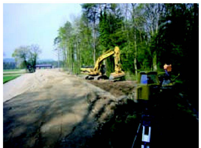
Abb. 3 und 4: Landwirtschaftliche Aufschüttung im Flaacherfeld (links): Das Material stammt aus den Thuraunen, wurde nach strengen Vorgaben bezüglich Kornverteilung aufbereitet und sorgfältig auf die vorbereiteten Felder verteilt; die 30 cm dicke Schüttschicht wurde anschliessend mittels Rotationsspatung mit dem Untergrund vermischt; die Folgebewirtschaftung dauert je nach Bodenentwicklung 3–4 Jahre. Neuer Hochwasserschutzdamm im Bau (rechts): Das Material stammt aus den Aufweitungen der Thur.
