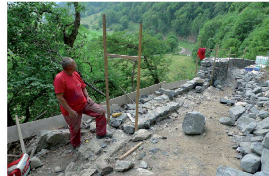
Abb. 3: Erhalten durch sachgemässes Instandstellen: Im Zug eines mehrere Etappen umfassenden Instandstellungsprojekts wird die 1495 eröffnete alte Schollbergstrasse zwischen Trübbach (Gemeinde Wartau SG) und Sargans wiederhergestellt und durchgehend begehbar gemacht (Ralph Gantenbein, LG Bau AG).
