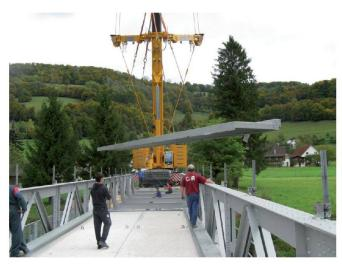
Fig. 5: Montage du nouveau tablier (grue avec élément de tablier).
