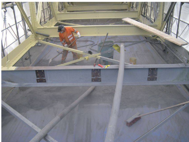
Fig. 4: Travaux de sablage.
