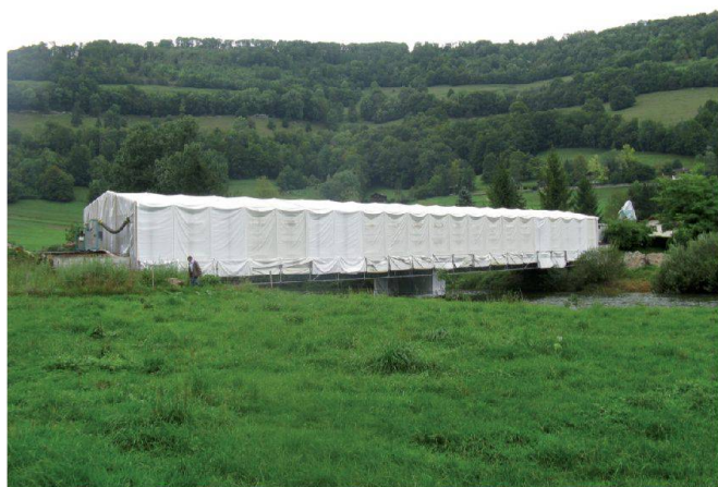
Fig. 2: Confinement pendant le chantier.
