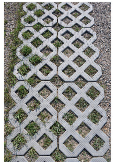
Abb. 2: Detail der Rasengittersteine aus Kunststoff-Recycling.
