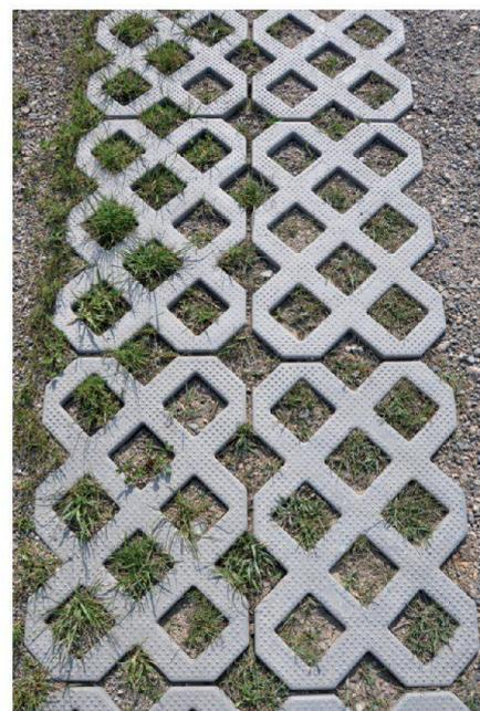
Abb. 2: Detail der Rasengittersteine aus Kunststoff-Recycling.
