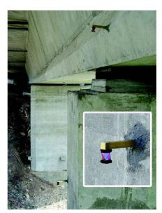
Fig. 6: Réflecteurs permanents sur un pont autoroutier.
