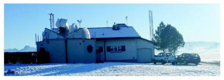
Abb. 1: Geostation Zimmerwald (von links): GPS-Mast, SLR-Teleskop und GNSS-Mast (GPS/GLONASS).
