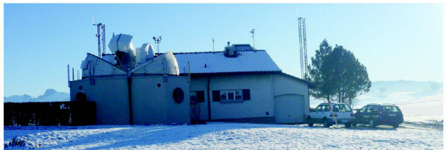
Abb. 1: Geostation Zimmerwald (von links): GPS-Mast, SLR-Teleskop und GNSS-Mast (GPS/GLONASS).
