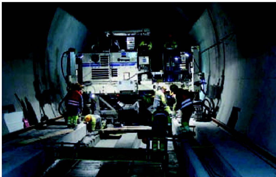
Abb. 8: Einbau der Gleistragplatte mit Schalungsfertiger.
