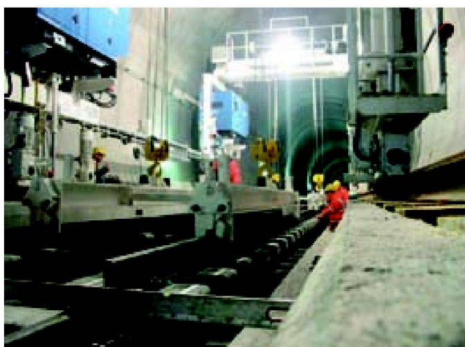
Abb. 4: Ablegen der 18-m-Gleisjoche.
