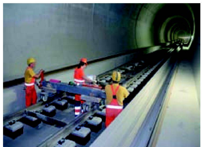
Abb. 5: Grob-Richten des Gleises.
