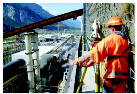
Abb. 4: Geodätische Vermessung auf der Bohrpfahlwand (Foto: Basler & Hofmann).
