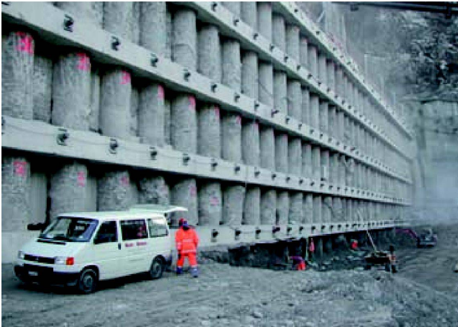
Abb. 2: Die rund 30 Meter hohe Bohrpfahlwand (Foto: Basler & Hofmann).
