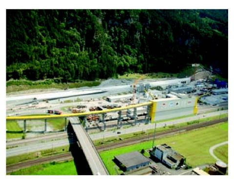
Abb. 1: Der Portalbereich bei Erstfeld: Die Bohrpfahlwand rechts sichert den Hangbereich unmittelbar vor dem bergmännischen Tunnelportal, links davon ist bereits der Tagbautunnel erstellt. Förderbänder und der Installationsplatz umgeben die Baustelle (Foto: AlpTransit Gotthard AG, Adrian Wildbolz).
