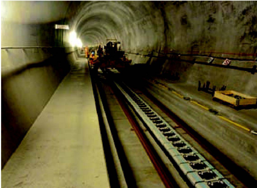
Abb. 4: Aufständern des Gleises im Abschnitt Bodio – Faido West.
