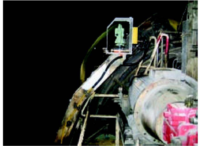
Abb. 6: Umlenkrahmen mit Maschinenstation.
