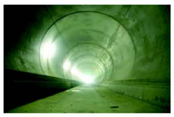
Abb. 9: Fertiger, ausbetonierter Tunnel.
