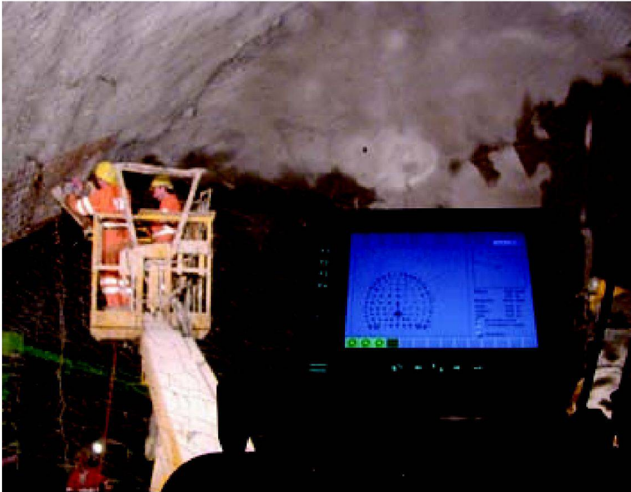
Abb. 2: Abbildung der zu bohrenden Löcher.
