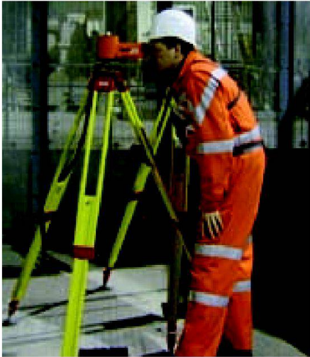
Abb. 4: Nadirlot am Schachtkopf.
