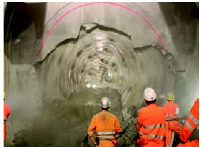
Abb. 12: Bohrkopf der Tunnelbohrmaschine im Moment des Durchschlags.
