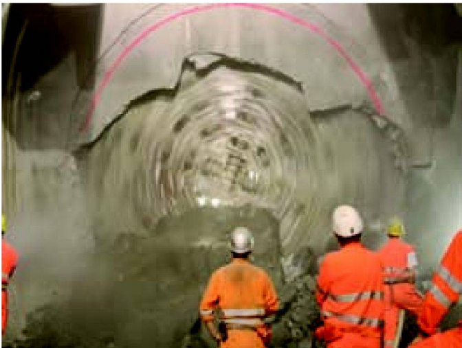
Abb. 12: Bohrkopf der Tunnelbohrmaschine im Moment des Durchschlags.
