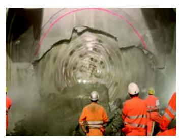
Abb. 12: Bohrkopf der Tunnelbohrmaschine im Moment des Durchschlags.
