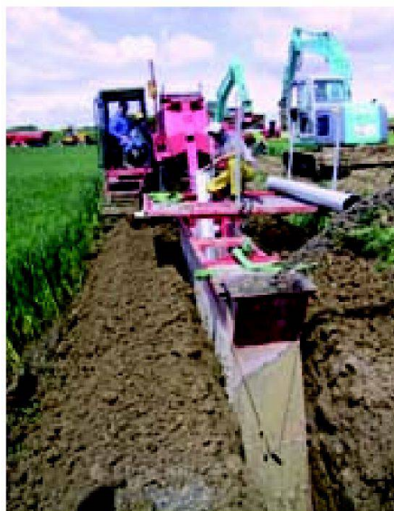
Fig. 3: Les techniques actuelles permettent des réalisations «tout en 1» compactes et rapides. Ici, pose d'un collecteur avec une «trancheuse à étayage glissant».
