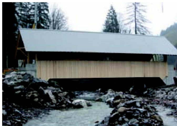
Abb. 9: Phase 4: Holzverkleidung als Wind- und Schneeschutz.
