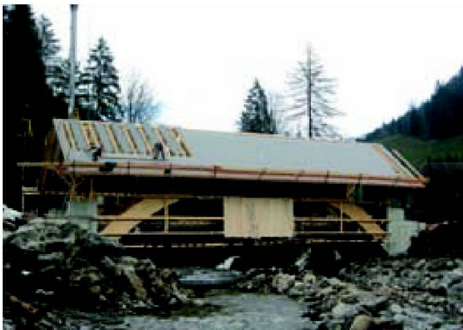
Abb. 8: Phase 3: Dachdeckerarbeiten.
