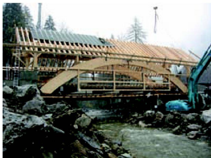
Abb. 7: Phase 2: Rohbau, Fahrbahnplatte mit Stahlhängepfosten an Gelenkbogen befestigt.
