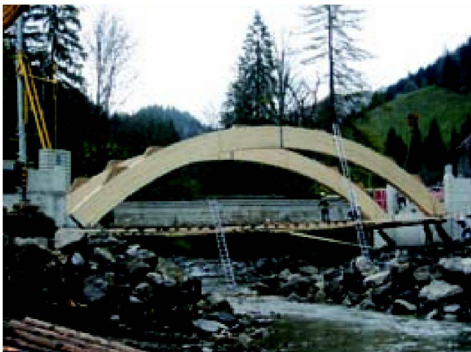
Abb. 6: Bauphase 1: Widerlager und Zweigelenkbogen.
