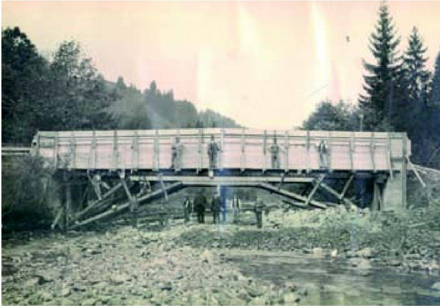
Abb. 3: Bau der Betonbrücke mit Lehrgerüst (1928).
