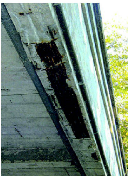
Abb. 4: Freigelegte Längsarmierung der Brückenuntersicht.
