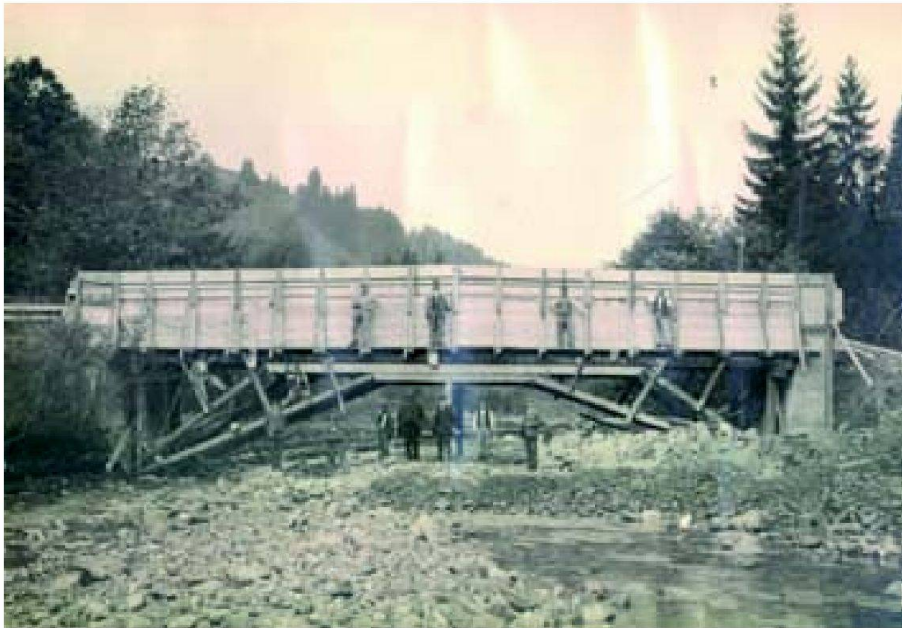
Abb. 3: Bau der Betonbrücke mit Lehrgerüst (1928).
