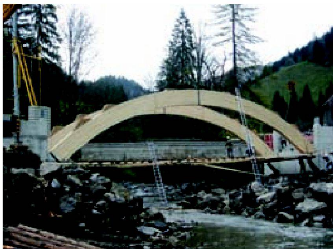
Abb. 6: Bauphase 1: Widerlager und Zweigelenkbogen.
