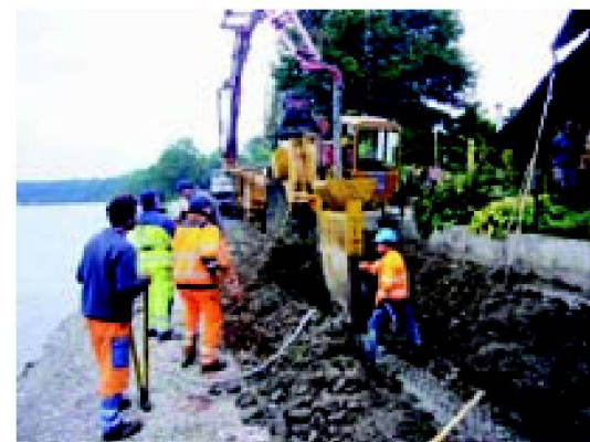
Abb. 4: Bau einer Betondichtwand.
