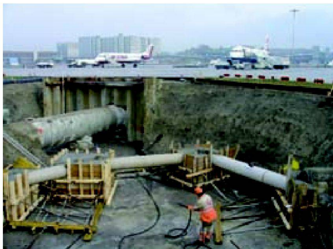
Abb. 2: Werkleitungsbau Abwasser. © Unique (Flughafen Zürich AG), 2009.
