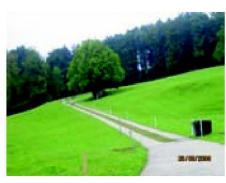
Abb. 2: Betonspurenweg mit grünem Mittelstreifen.
