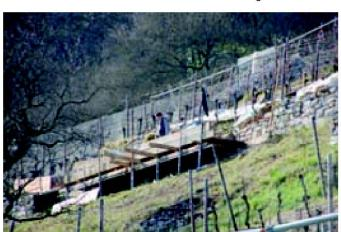
raks zum Einsatz. Für den Mauerbau werden ausschliesslich Bruchsteine aus Jurakalk verwendet.
