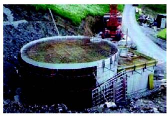
Abb. 3: Reservoir Innerthal SZ: gute Zufahrt, klares Baukonzept, einfacher Unterhalt.
