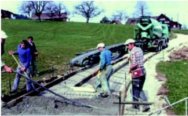
Abb. 6: Spurwegebau in Mosnang SG.
