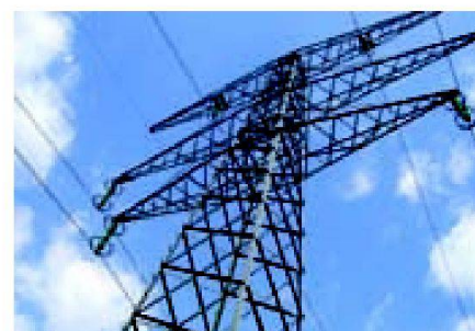
Fig. 2: Les lignes électriques peuvent parfois être une source de courants vagabonds.
