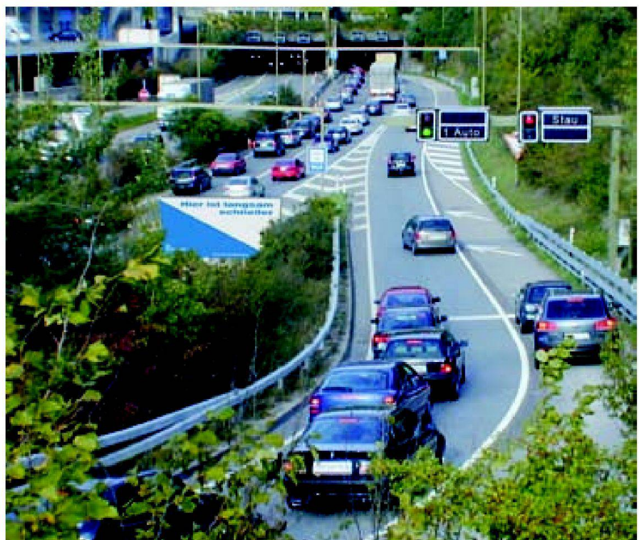
Abb. 2: Beispiel der intelligenten Strassennutzung: Damit der Verkehr auf der Autobahn nicht zusammenbricht, wird jener auf der Einfahrt dosiert (A20 Weiningen. Quelle: Tiefbauamt Kanton Zürich, Planung + Steuerung).
