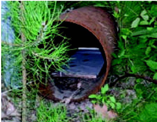
Abb. 4: Solche Metallröhren werden in Holland «badger pipes» genannt. Sie sollen den Dachsen das Queren stark befahrener Strassen erleichtern und die Verkehrsmortalität senken. Der Papierstreifen in der Röhre ist eine Methode der Erfolgskontrolle.
