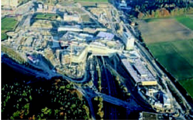
Abb. 1: Die WESTside: die Grossbaustelle.
