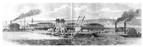
Abb. 4: Schottische «Floating Railway», die zwischen Burntisland und Granton den Meerarm Firth of Forth überquerte, als Vorbild für die projektierte schwimmende Eisenbahn auf den Juraseen.
