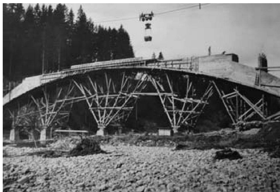
Abb. 1: Bauausführung Rosigrabenbrücke mit Lehrgerüst und Bauseilbahn (Aufnahme vom 10. Oktober 1932, aus Archiv ASP-BE).
