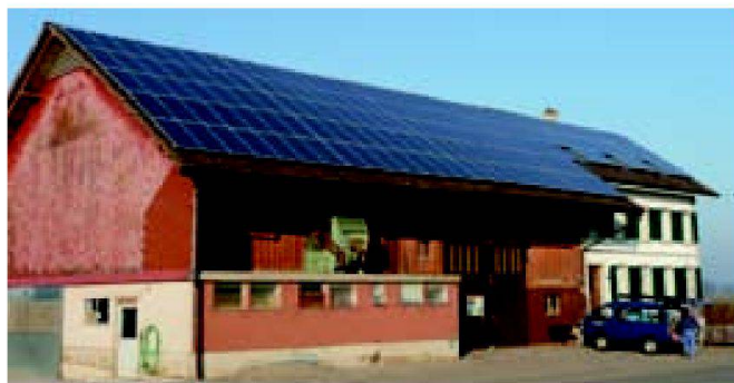
Abb. 1: Die 161 Module zu 180 W Leistung, zusammengesetzt aus je 50 polykristallinen Solarzellen, ergeben eine kompakte Fotovoltaik-Aufdach-Anlage mit ansprechender Leistung auf dem bestehenden Scheunendach und Wohnhaus.
