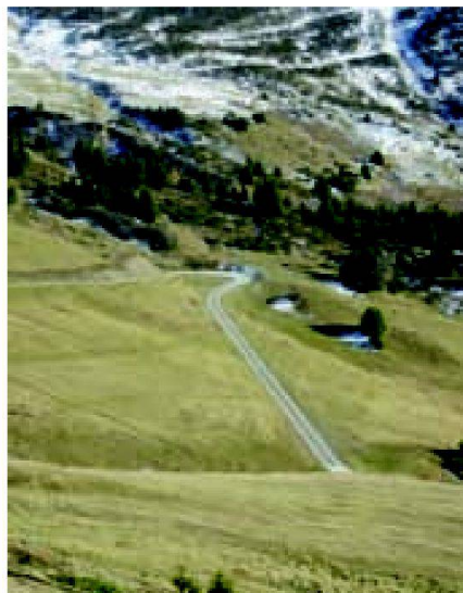
Fig. 1: Intégration dans le paysage d'un chemin alpestre (Alp dil Plaun, GR) réalisé avec des bandes de roulement en béton préfabriqué. Dans les virages serrés, le chemin est bétonné sur toute la largeur pour éviter l'empiètement des véhicules.
