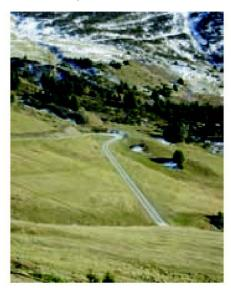
Fig. 1: Intégration dans le paysage d'un chemin alpestre (Alp dil Plaun, GR) réalisé avec des bandes de roulement en béton préfabriqué. Dans les virages serrés, le chemin est bétonné sur toute la largeur pour éviter l'empiètement des véhicules.
