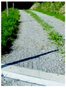
Fig. 2: Bandes de roulement en matière synthétique pour l'accès à l'alpage du Stützli, Jaun (FR). Après quelques mois déjà, la bande médiane est végétalisée. La gestion des eaux superficielles n'est possible qu'avec des rigoles soignées et suffisamment nombreuses (écart: env. 20–30 m).
