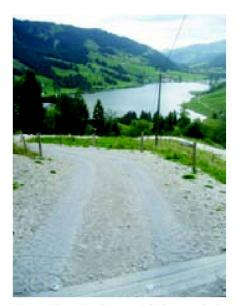
Fig. 5: Chemin d'accés à l'alpage de la Breccaschlund (Lac Noir FR) en bandes de roulement avec des pavés ajourés en béton et des éléments préfabriqués (au premier plan) pour l'évacuation des eaux de surfaces.
