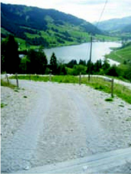
Fig. 5: Chemin d'accès à l'alpage de la Breccaschlund (Lac Noir FR) en bandes de roulement avec des pavés ajourés en béton et des éléments préfabriqués (au premier plan) pour l'évacuation des eaux de surfaces.
