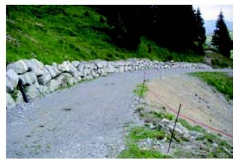
Abb. 2: Wiederherstellung eines Güterwegs mit rekultivierter Böschung, Lenk (BE).
