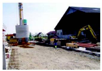
Fig. 1: Etape de construction des fondations et radier de l'annexe du rural existant (Source: Service du développement territorial Vaud).
