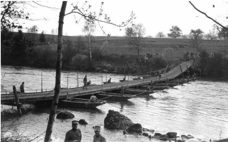
Abb. 10: Schweizer Armee: Pontonier-Bataillon 3. Einbau der Birago-Brücke im WK 1934. Feste und schwimmende Auflager kombiniert. Überwindung eines Steilufers (BAUT 2002).
