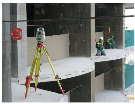
Abb. 4: Absteckungsarbeiten für die Fassadeninstallation.
