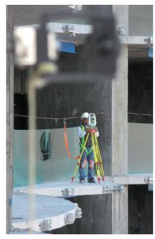
Abb. 3: Aufstellung eines Instrumentes im Zentrum für Kontrollaufnahmen. Die Konsolen sind bereits montiert.
