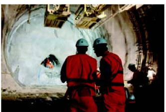
Die Durchschlagsresultate von Bodio – Faido und von Amsteg – Sedrun zeigen, dass die beteiligten Vermesser hervorragend gearbeitet haben. Weiter bestätigten sich die Qualität des oberirdischen Grundlagennetzes sowie die Modellannahmen für die im Alpenraum stark variierenden Lotabweichungen und Schwereverhältnisse, mit denen die Messwerte korrigiert wurden.
