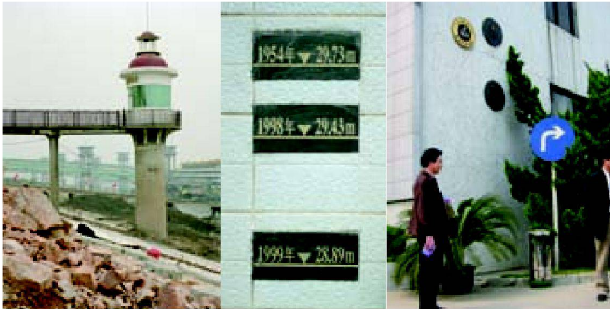
Abb. 1: Im Umbau befindliche Uferverbauung in Wuhan mit hydrologischer Station; im Hintergrund den Pegelschwankungen angepasste Piers (links); Hochwassermarken an der Verbauung entlang des Changjiang in Wuhan (Mitte) und die entsprechenden Marken am Gebäude des CWRCs (rechts); deutlich erkennbar ist, wie stark Wuhan von den Hochwassern betroffen war, bevor die neuesten Hochwasserschutzmassnahmen erfolgt sind (© MFB-GeoConsulting).
