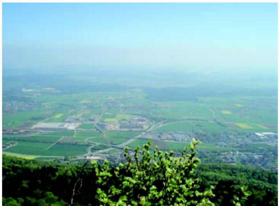
Abb. 1: Gäu SO: Wie geplant so gebaut!
