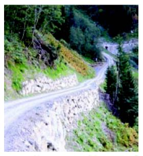
Abb. 2: Neue Linienführung mit aufwändigen Böschungssicherungen.
