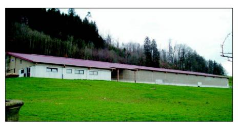
Abb. 1: Gesamtansicht des neuen Milchvieh-Boxenlaufstalles der Gemeinschaft. Im Vordergrund der Raum für das Milchzimmer und das Melk-Karussell. Anschliessend der Warteraum der Kühe vor dem Melken (überdacht) und der Laufhof entlang der Südseite des Gebäudes.
