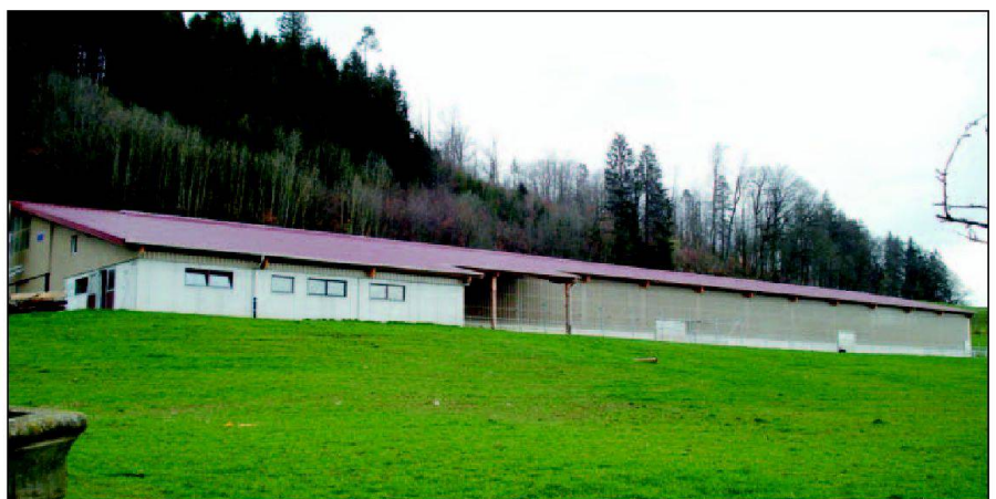
Abb. 1: Gesamtansicht des neuen Milchvieh-Boxenlaufstalles der Gemeinschaft. Im Vordergrund der Raum für das Milchzimmer und das Melk-Karussell. Anschliessend der Warteraum der Kühe vor dem Melken (überdacht) und der Laufhof entlang der Südseite des Gebäudes.
