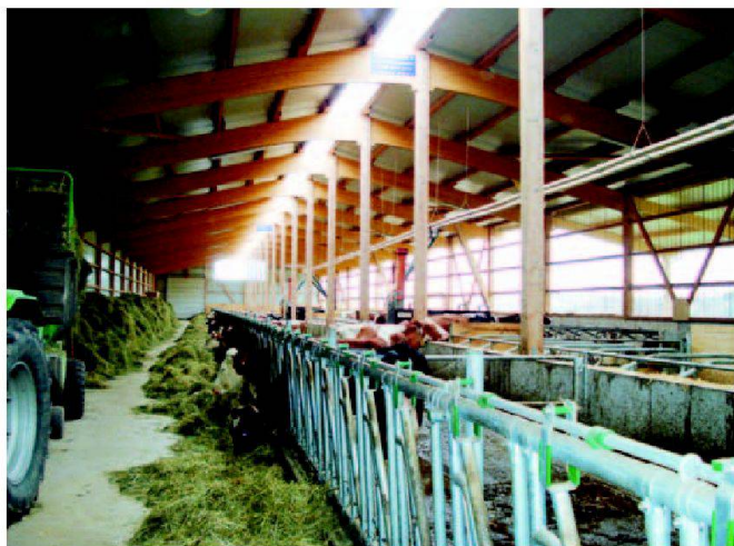
Abb. 2 und 3: Futterachse mit Fressplatz und zweireihiger Boxenanordnung; eine abgesetzte Lichtfirst und die Verkleidung der südlichen Längsseite des Stalles mit perforiertem Blech sorgen für Helligkeit und für ein gutes Stallklima. Rechts: Melk-Karussell (16 Plätze).
