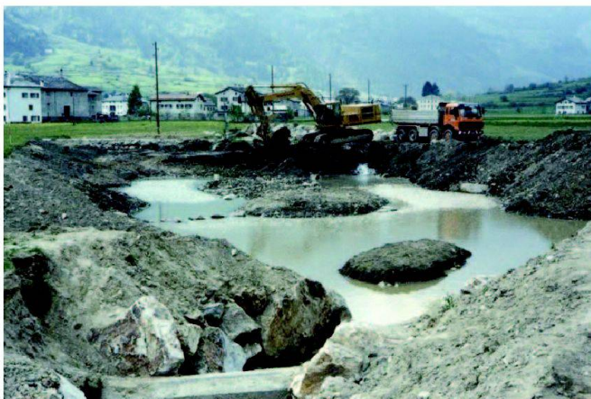
Abb. 6 und 7: Als Ersatzmassnahme für diverse zugedückte kleine Entwässerungsgräben wurde ein neues Biotop beim Zusammenfluss von drei Entwässerungskanälen geschaffen.
