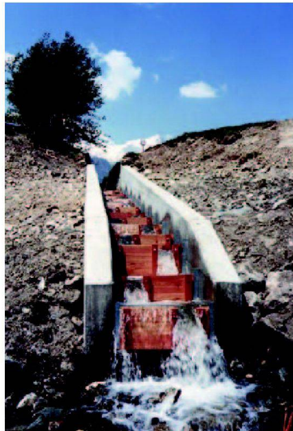
Abb. 5: In der Laichzeit im November ermöglicht eine Fischtreppe den Aufstieg der Forellen bei tiefem Pegelstand des Lago di Poschiavo in den Entwässerungsgraben.
