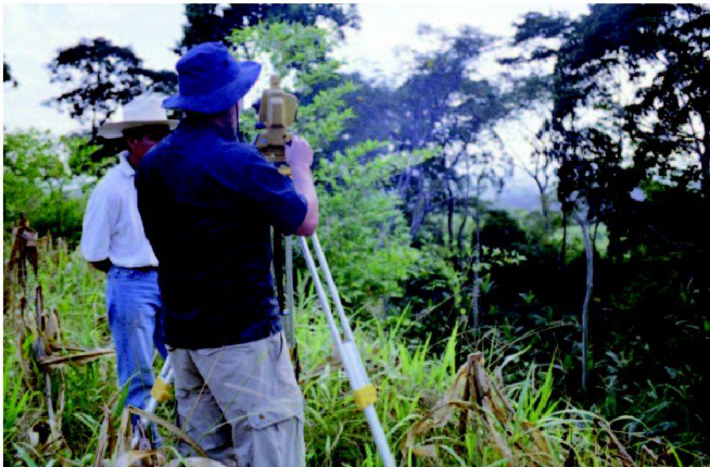
Abb. 1: Vermessungsarbeiten unter Einbezug lokaler Fachkräfte.
