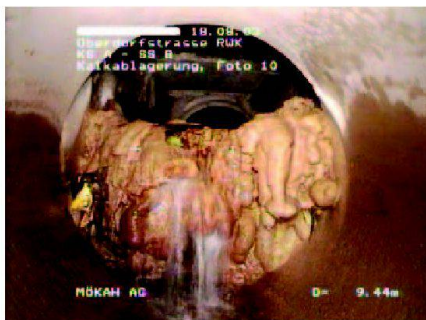
Abb. 3: Ein kräftig verockertes Sammlerrohr.
