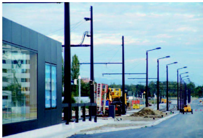
Abb. 6: Einheitliche Gestaltung der Fahrleitungs- und Beleuchtungsmasten.
