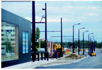
Abb. 6: Einheitliche Gestaltung der Fahrleitungs- und Beleuchtungsmasten.
