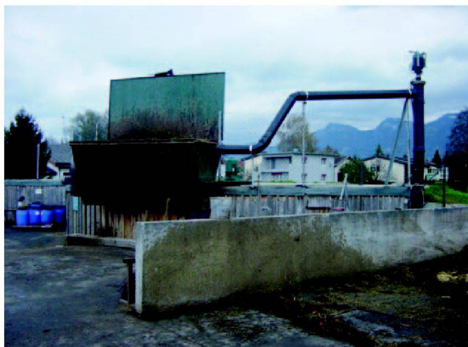
Fig. 3: Au premier plan sont stockés les cosubstrats. Le silo enterré au centre de l'image est surmonté d'un conteneur équipé d'une vis permettant d'introduire les cosubstrats. A l'arrière plan on distingue un 2 e silo enterré réservé à la postfermentation.
