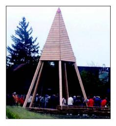
lität zu verleihen und um seinen Wert zu kennzeichnen, wurde eine Holzpyramide über dem Vermessungsstein gebaut. Eine ähnliche Holzpyramide, deren Höhe damals 14,6 Meter war, überdachte auch vor 200 Jahren das Basisende und diente als Vermessungssignal, damit die einzelnen Punkte über grosse Distanzen angepeilt werden konnten. Die drei neben dem Denkmal aufgestellten Holzstapel sind in Peilrichtung der nächstgelegenen Triangulationspunkte Sugiez, Chasseral und Montoz ausgerichtet.
