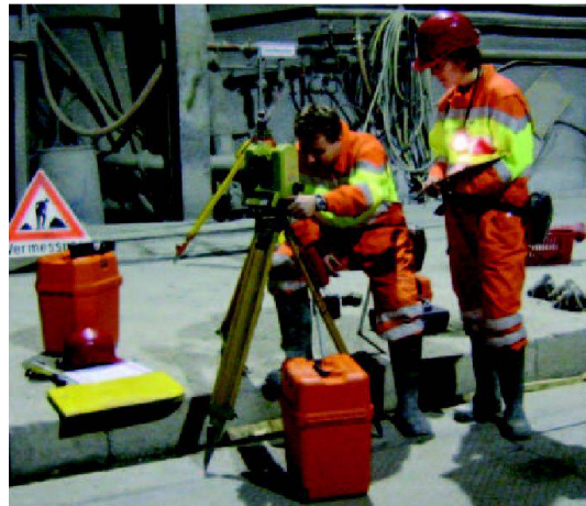
Abb. 5: Theodolit-Standpunkt in der Schachtfusskaverne.
