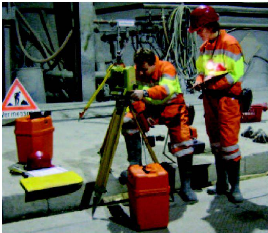
Abb. 5: Theodolit-Standpunkt in der Schachtfusskaverne.
