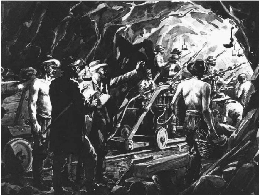
Abb. 3: Bohrarbeiten am Gotthard-Bahntunnel.
