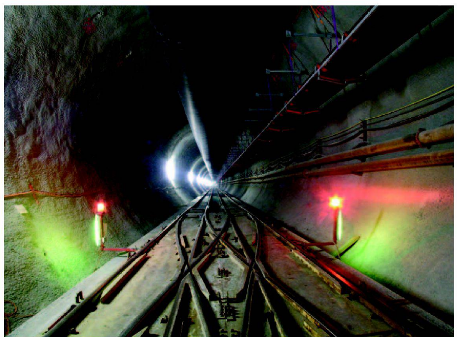
Abb. 5: Betonierte Sohle mit Baugeleise in Amsteg.
