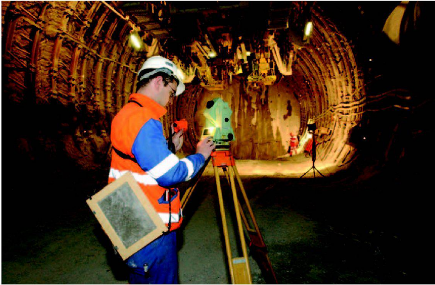
Abb. 2: Stollenkontrolle im Vortrieb Nord West in Sedrun.
