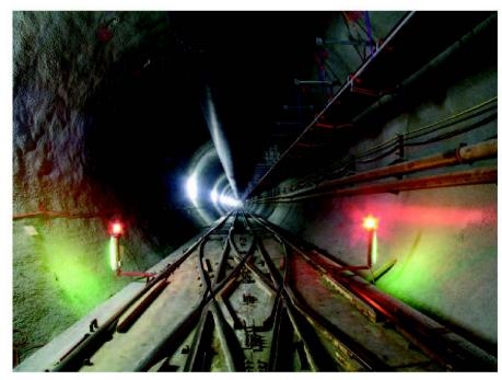
Abb. 5: Betonierte Sohle mit Baugeleise in Amsteg.
